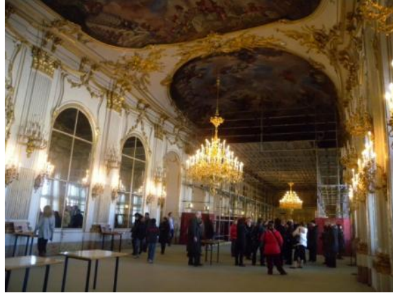
... la grande galerie en travaux !
