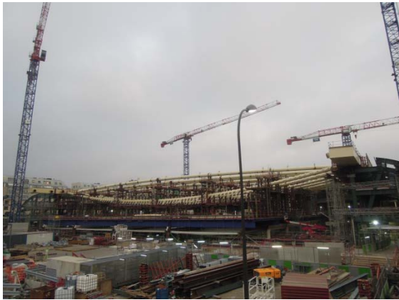
Les Halles, travaux de la Canopée
