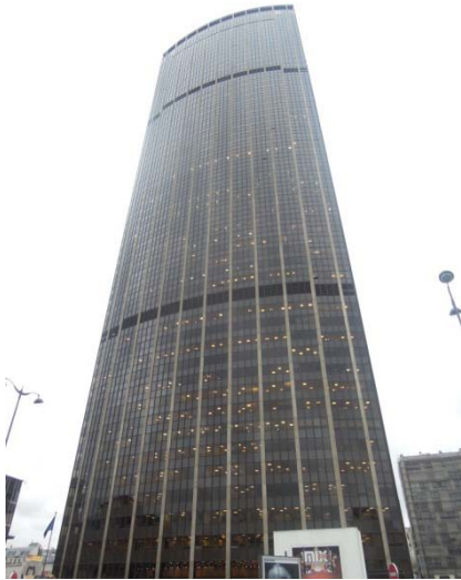
La tour Montparnasse
