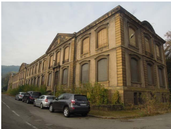
Château de Wendel à Hayange
