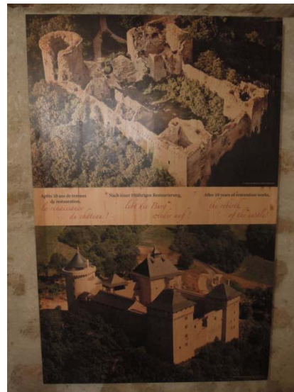
Le château avant et après restauration
