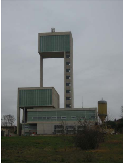
Château d'eau de Leudelange
