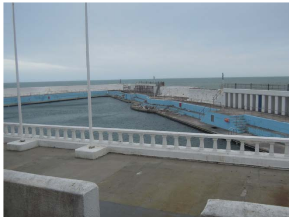
Magnifique piscine endommagée par la tempête
