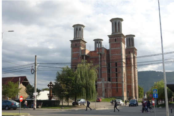
Eglise en construction
