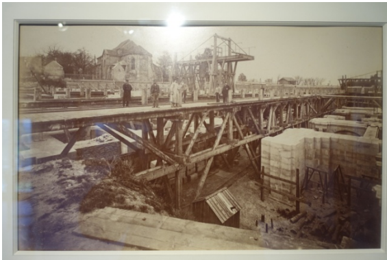
Chantier du Sacré Cœur 1879
