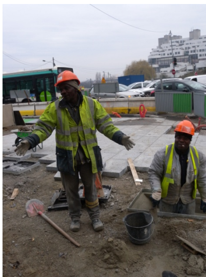
Les travaux du tramway
