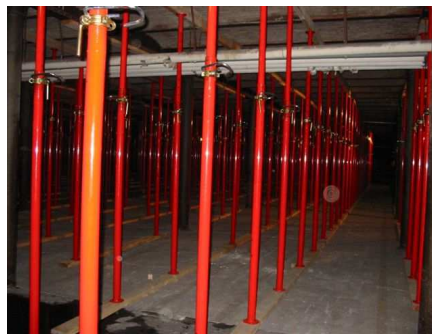
remise des bois de cercueil en sous-sol, futur salle technique
