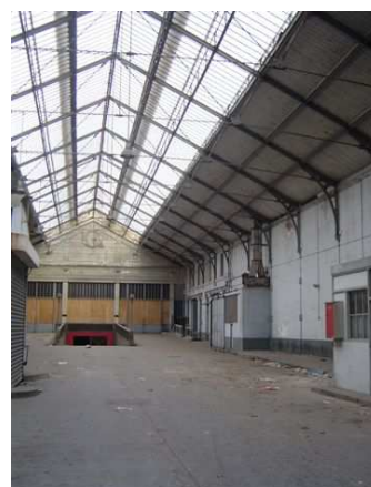
au fond, le mur de l'ancien atelier de mécanique qui sera détruit et la décente aux écuries, lieu des futurs salons et événementiels
